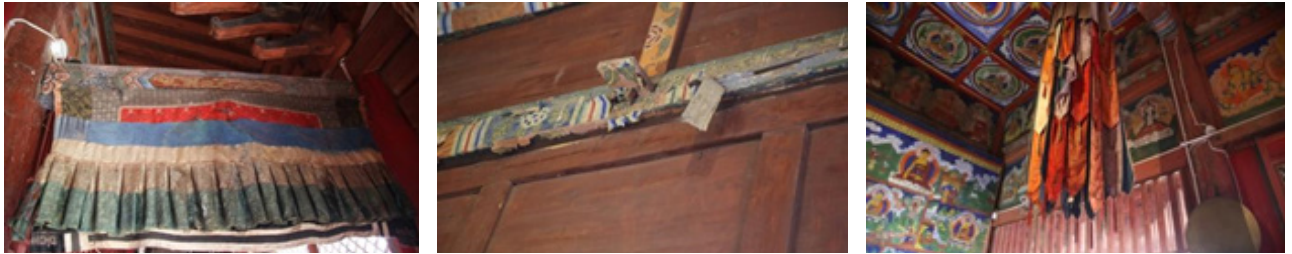
Хадаасаар хадаж тогтоосон, сэмэрч урагдсан, баганы чимэглэл зураг урагдаж ховхорсон. Бадам, жанцан их урагдаж муудсан тул сэргээн засварлаж амрах шаардлагатай.
