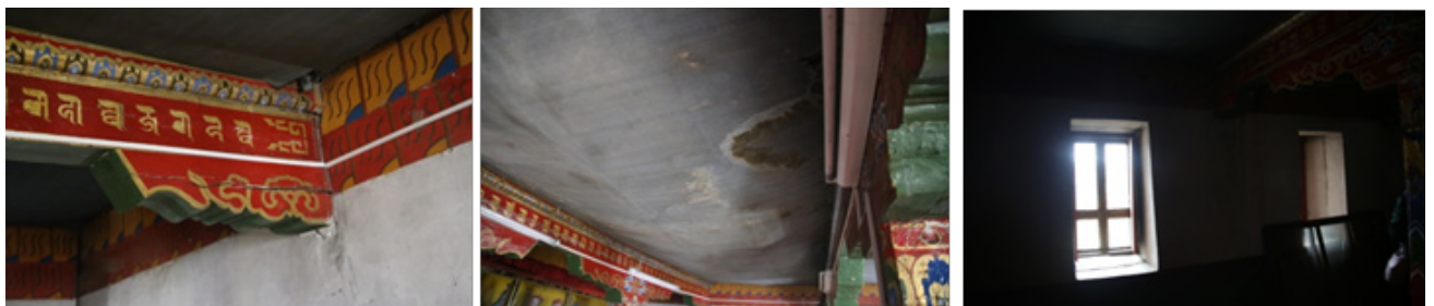
Дээвэрээсээ ус гоожсоны улмаас дээвэр голоороо суулт өгсөн. Тулгуур багана ба хана цуурсан, цонхнууд хөшиг хаалтгүй онгорхой байлаа.
