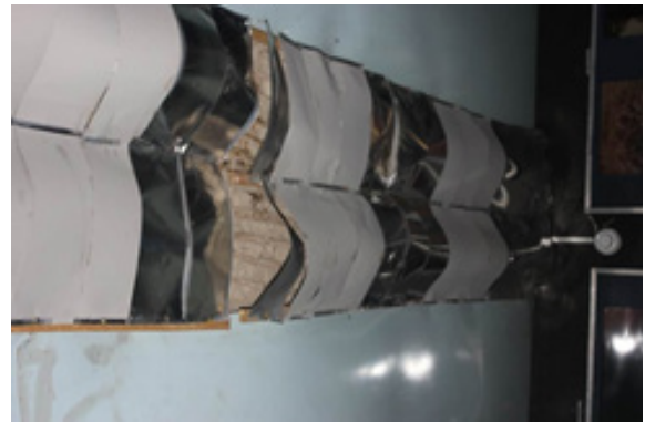
Дүүжин таазны дээрээс шавар унж хүндэрснээр нурах эрсдэл үүссэн байна
