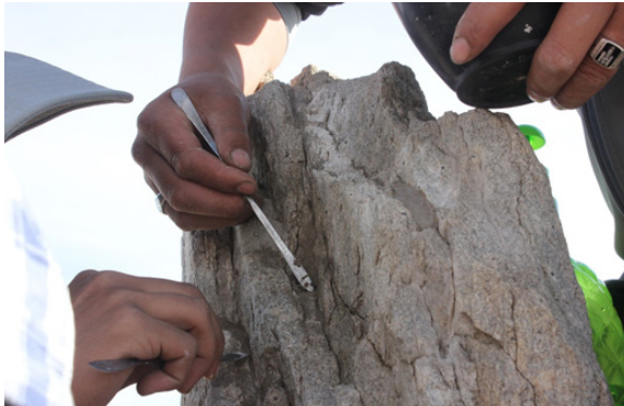
Зураг 28: Дүүргэгчээр чулуун дурсгалыг ан цав, цуурлыг нөхсний дараа
